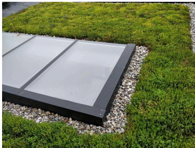
Eerste jaar van aanleg sedumdak.
