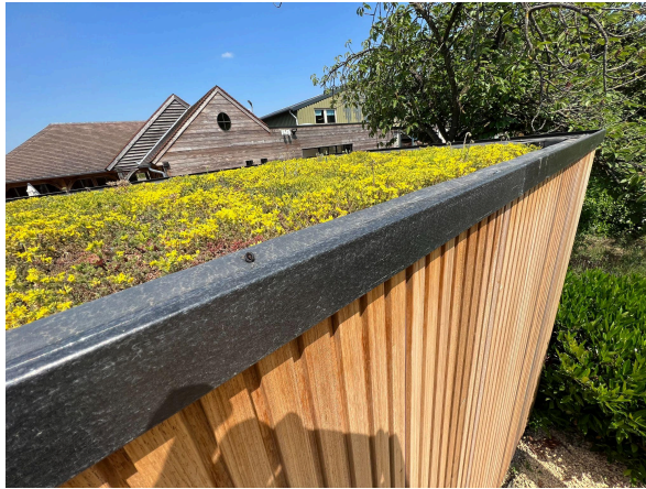
Eerste jaar na aanleg groendak, sedum in bloei.
